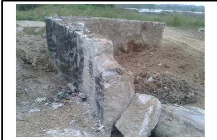
Demolición de muros ≠ 20 cm.
